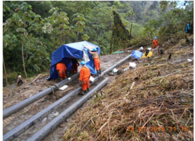
**Figura 7.12.** Montaje de Line Stop (TGP)
