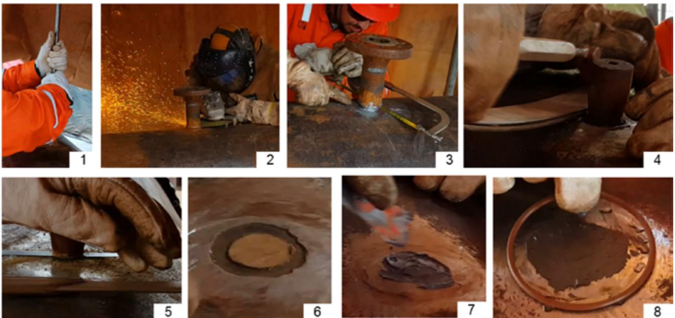
A continuación, es presentada detalladamente la secuencia para la remoción de la derivación clandestina y preparación para la instalación de la abrazadera doble, ilustrada en la Figura 7.4.
